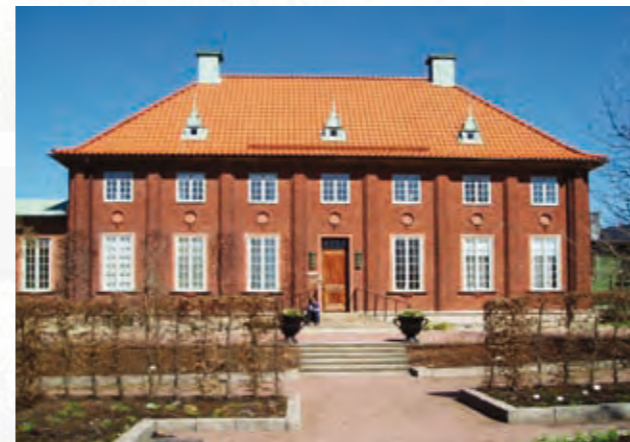
Das ehemalige Prefäktoresgebäude, heute Verwaltung und Bibliothek des Botanischen Gartens Göteborg
