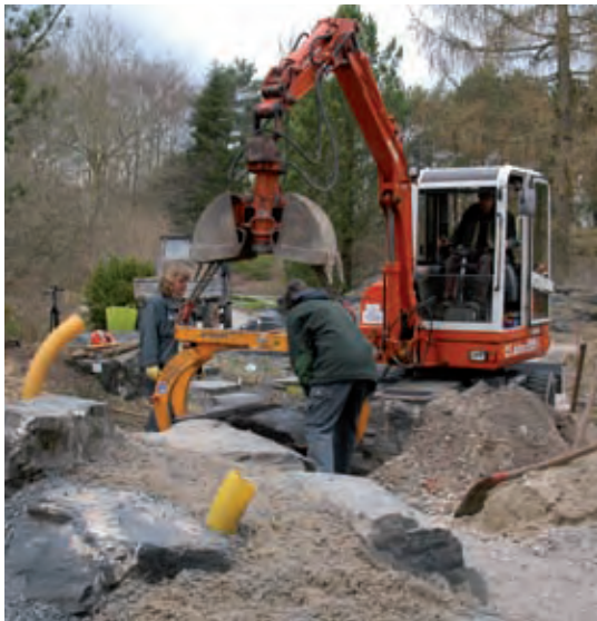
Ein Gebirge entsteht... - Steinsetz-Arbeiten im Alpinum.
